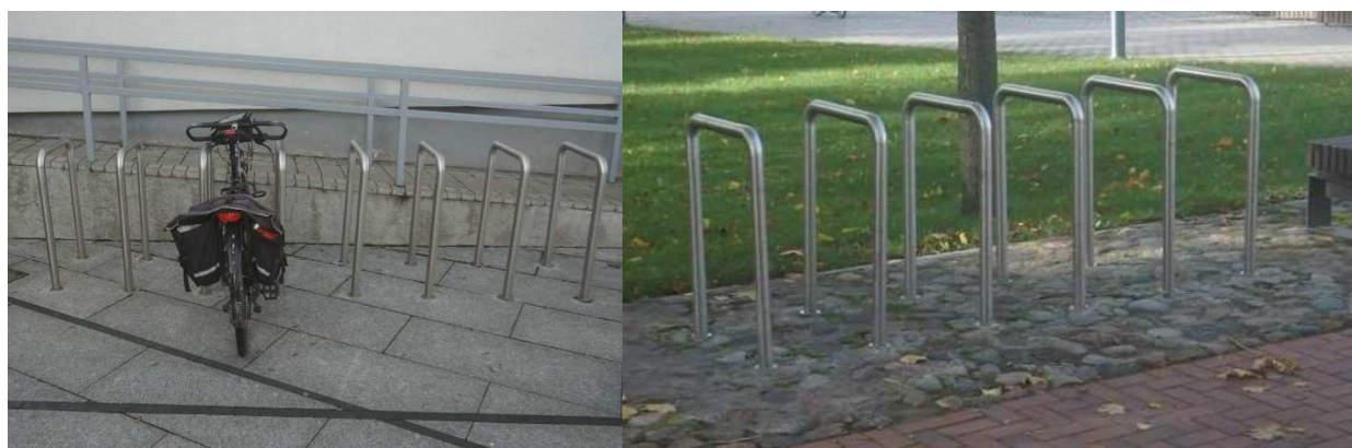
106 Pav. Netinkamai įrengtų dviračių stovų pavyzdys (tarpai tarp gretimų stovų neatitinka norminio atstumo), (Marijampolė)
