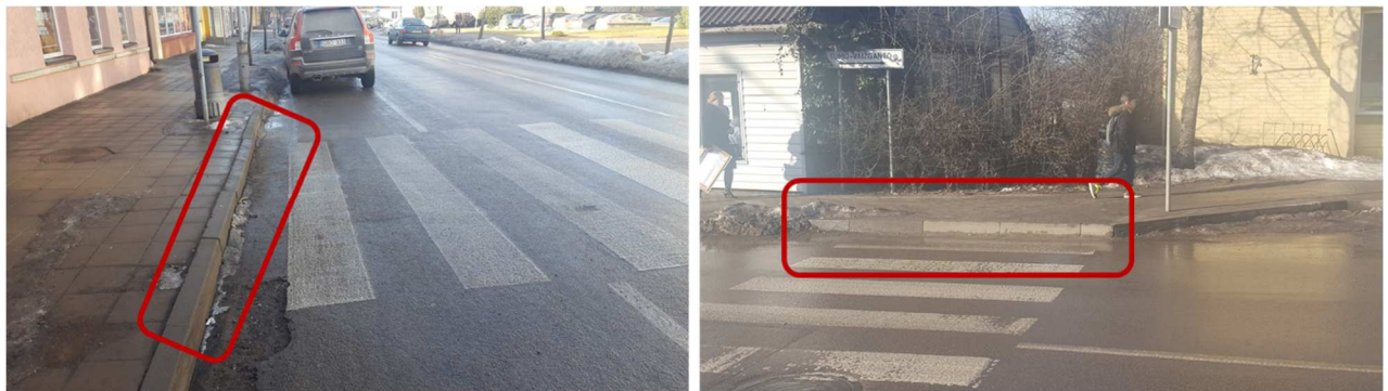
86 Pav. Plungės mieste esančių pėsčiųjų perėjų būklė Šaltinis: sudaryta Konsultanto
