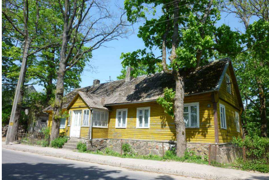
Pav. 2 2 kompleksinės vertės (vertingo) pastato pavyzdys
