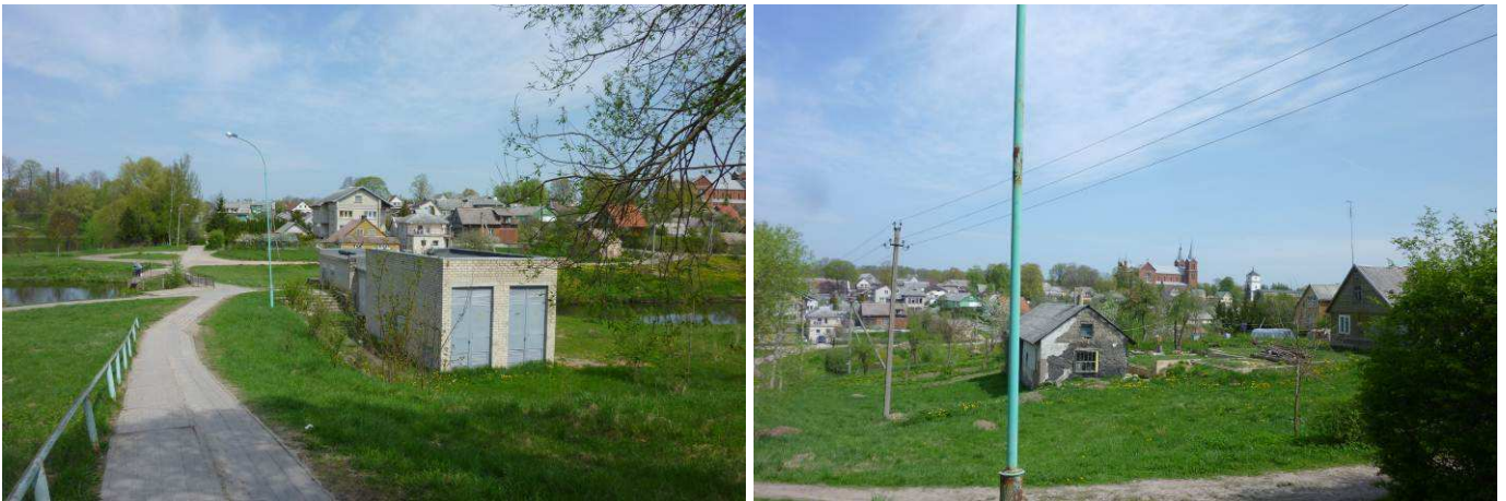
Pav. 17 Infrastruktūros objektai – transformatorinės, orinės el. linijos
