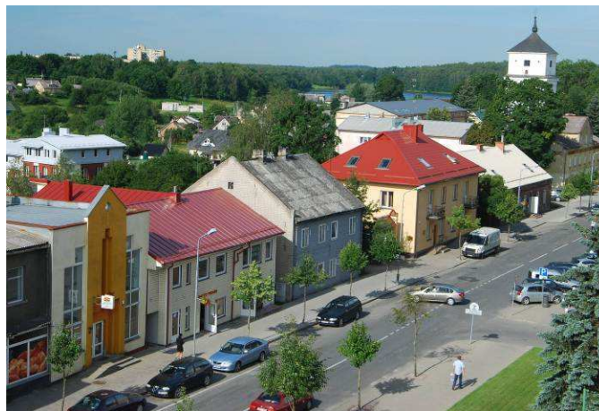
Pav. 5 Tinkami pastatų restauravimo, remonto ir rekonstravimo pavyzdžiai
