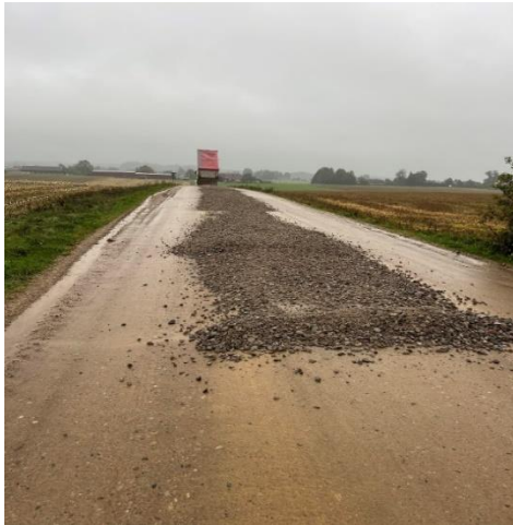
5, 6 pav. Šateikių Rūdaičių k. Ramioji g. dangos atnaujinimas pilant žvyro ir skaldos sluoksnius
