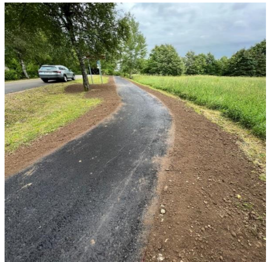
10 pav. Pėsčiųjų-dviračių tako remontas
