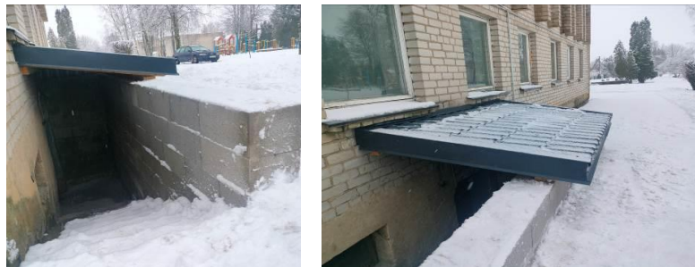
10 pav. Administracinio pastato laiptų į rūšį remonto darbai (po)
