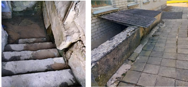
9 pav. Administracinio pastato laiptų į rūšį remonto darbai (prieš)
