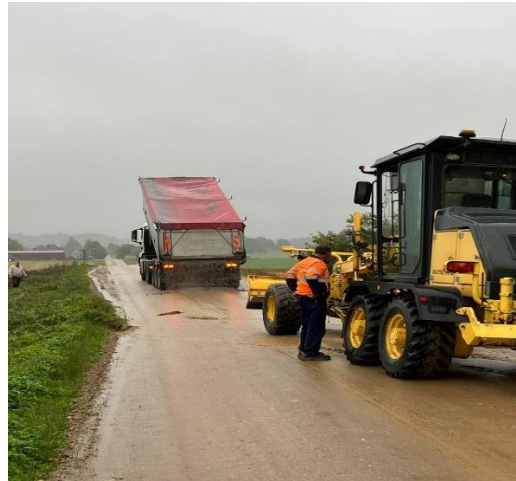
5, 6 pav. Šateikių Rūdaičių k. Ramioji g. dangos atnaujinimas pilant žvyro ir skaldos sluoksnius
